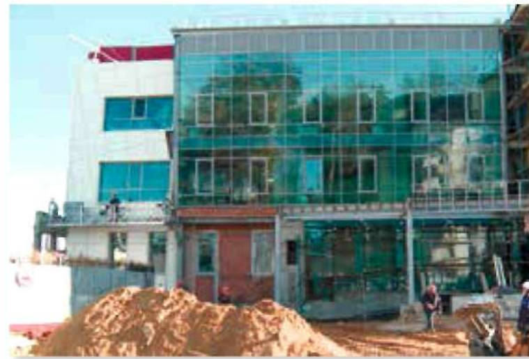
На данный момент практически полностью выполнена облицовка здания Центра боевых искусств
